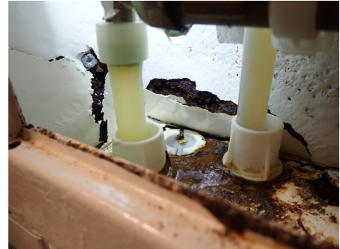
Rustskader i r-i-r skap
