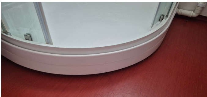
Sluket ligger under dusjkabinettet
