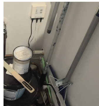
Gjennomføring i gulv og vegg
