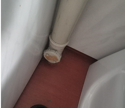
Gjennomføring i gulv uten mansjett
