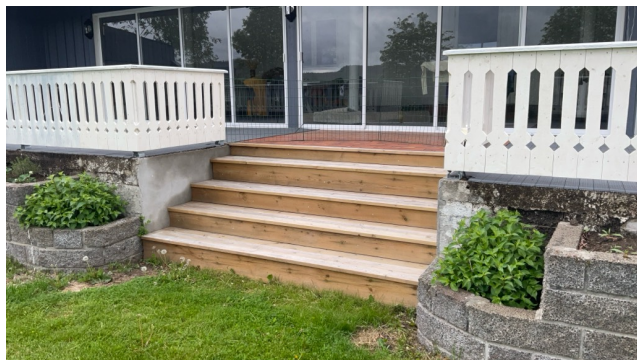
Trapp til terrasse.
