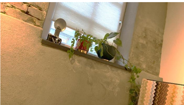
Venstre foto fra befaring 07.10.22. Høyre foto fra befaring 23.03.23 viser betydelig kraftigere saltutslag under vindu i stue.
