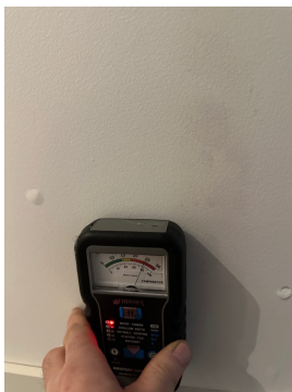
Vegg mellom gang og vaskerom.
