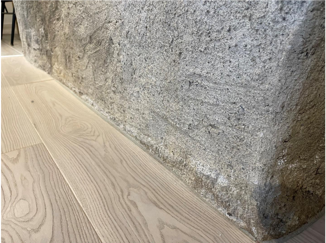
Bilde tatt i bunnen av pipen i september 2022
