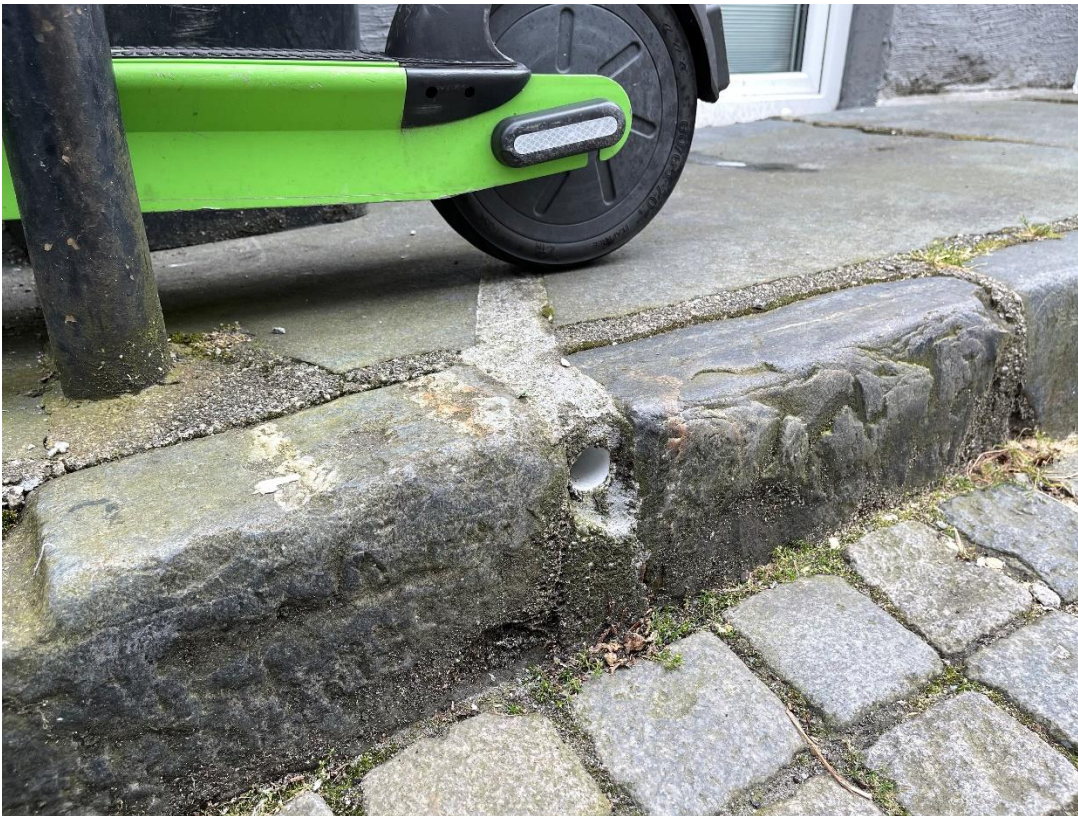
Bilde av rør som kommer ut ved fortauskanten, røret ligger oppover langs grunnmuren for vinduene
