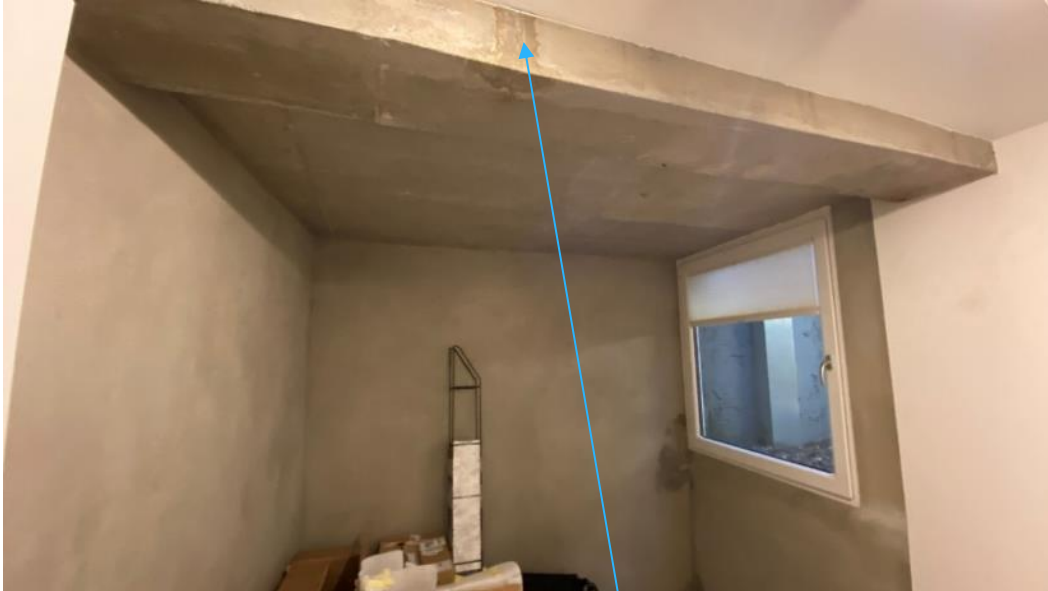
Renninger etter vann gjennom himling ved bærebjelke av betong. Også vått i gipshimling. Rom utfor bjelke er påstøpt trolig i 2016.
