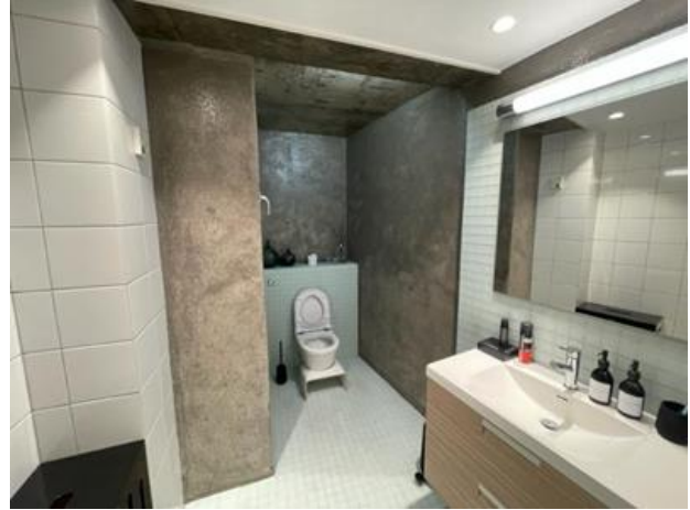
Bod er over baderom
