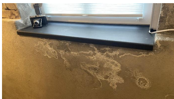
Venstre foto fra befaring 07.10.22. Høyre foto fra befaring 23.03.23 viser betydelig kraftigere saltutslag under vindu i stue.
