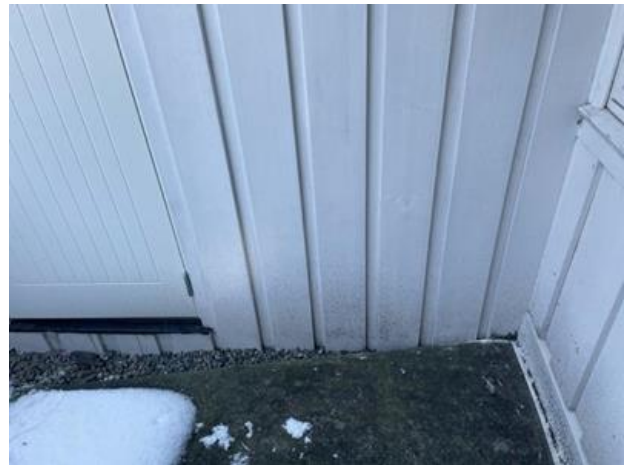
Inntreksvei mellom kledning og støpt dekke.
