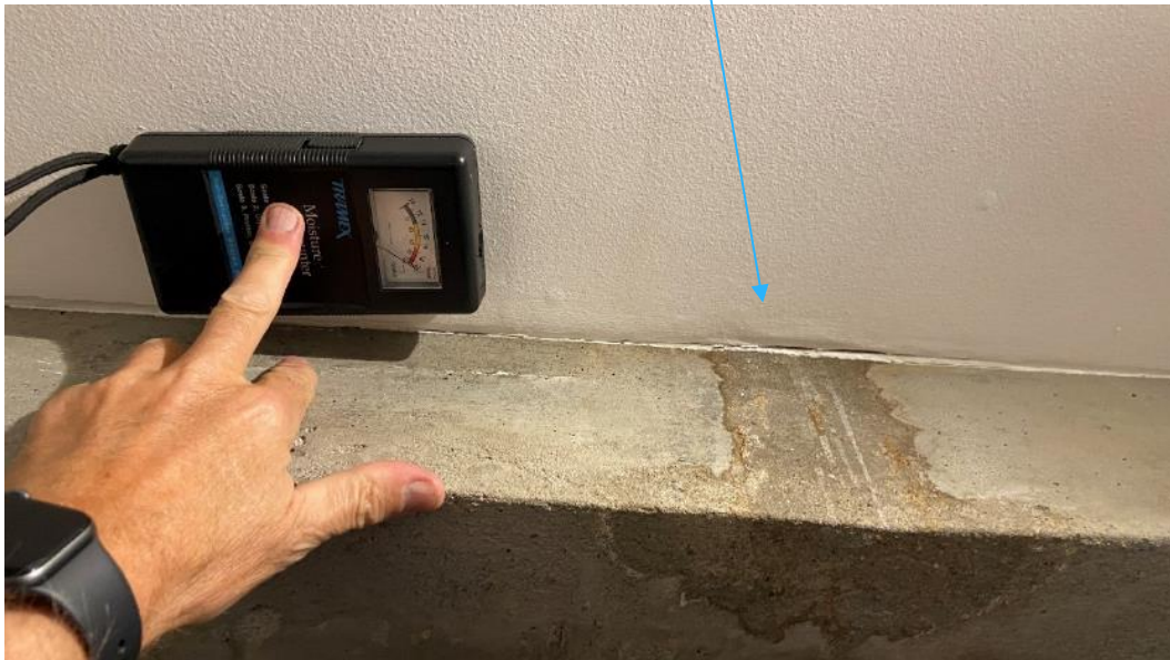
Renninger etter vann gjennom himling ved bærebjelke av betong. Også vått i gipshimling. Rom utfor bjelke er påstøpt trolig i 2016.
