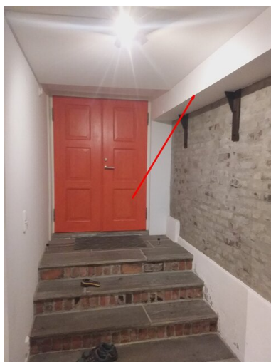
Pil viser innkassing til drager, som fukt følger.
