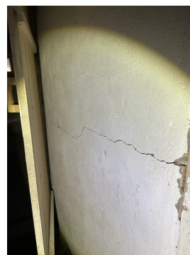
Registrert sprekkdannelse i grunnmuren.
