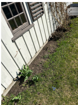
Ikke synlig fuktsikring av grunnmuren utvendig.
