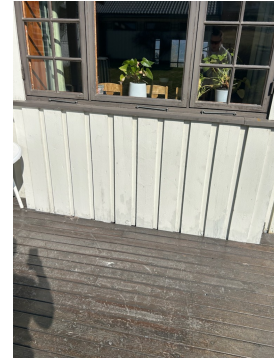
Kledningen fremstår som værslitt.
