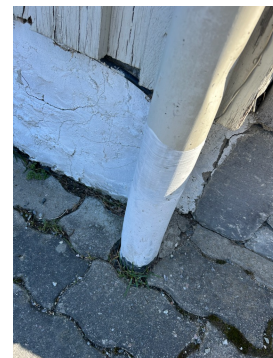
Taknedløp er trolig tilkoblet det gamle dreneringssystemet fra 1976. Dette kan på grunn av alder være tilstoppet, og ved å lede vannet inn i det gamle systemet er det økt risiko for vanninntrengning i grunnmur.
