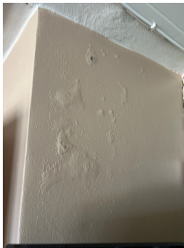
Flassing av pipens overflatebehandling.
