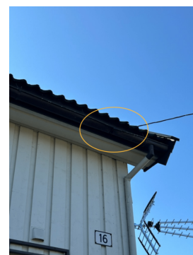
Taknedløp er trolig tilkoblet det gamle dreneringssystemet fra 1976. Dette kan på grunn av alder være tilstoppet, og ved å lede vannet inn i det gamle systemet er det økt risiko for vanninntrengning i grunnmur.
