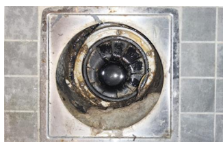
Vannnett sjikt / membran i gulv og vegger - Hovedsluk bad
