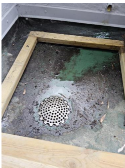
Membraner og vanntett sjikt - Sluk på balkong.
