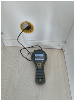
Utført kontroll i tilliggende konstruksjon - Fuktmåling
