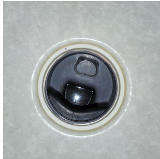
Avløp (inkl. sluk) - Sluk dusjsonen
