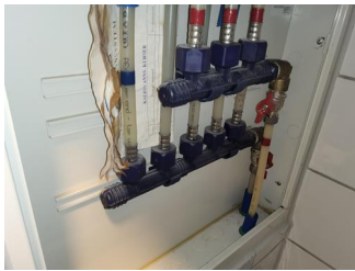
Fordelerskap og fordelerstammer - Fordelerskap for rør-i-rør system
