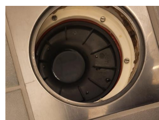
Avløp (inkl. sluk) - Sluk
