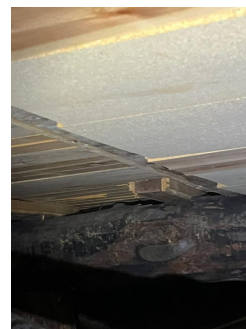
Ingen synlige skader i del av krypkjeller med tilkomst.
