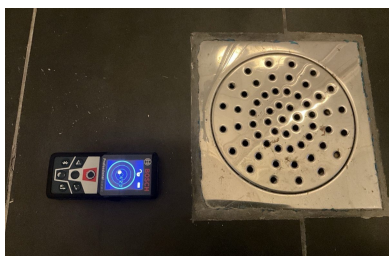
Bilde 17 — Måling av fall til sluk
