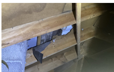
Bilde 4 — Utetthet i undertak
