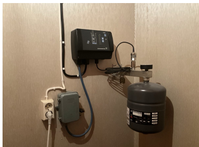
Bilde 27 — Grundfos styreenhet for pumpe, samt ekspansjonskar
