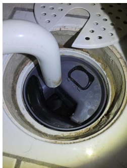
Tettesjiktets tilslutning til sluk - Sluk under badekar.
