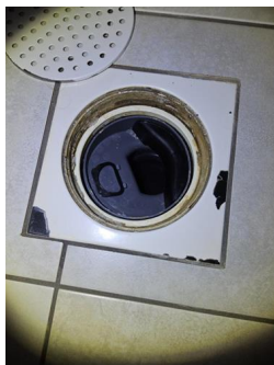
Tettesjiktets tilslutning til sluk - Sluk i dusjsønen.
