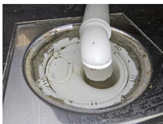
Tettesjiktets tilslutning til sluk - Sluk under innredning.
