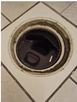
Tettesjiktets tilslutning til sluk - Sluk under servantinnredning.
