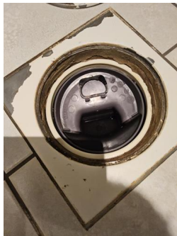
Tettesjiktets tilslutning til sluk - Sluk i dusjsonen.
