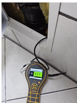
Kontroll i lukkede konstruksjoner - Fuktfuktmåling.
