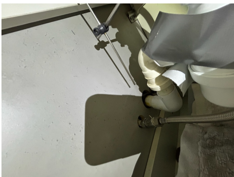
Rørgjennomføringer i vegg.
