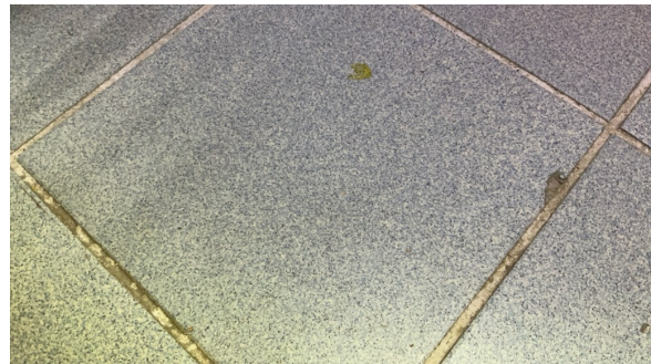
Punktskade gulvflis
