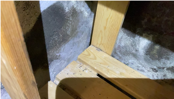
Tegn til fuktgjennomtrenging, kjellerbod sør
