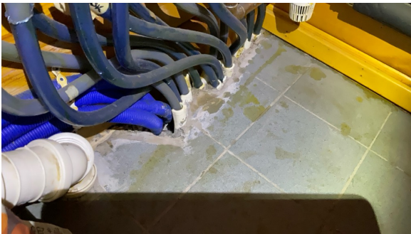
Oversiktsbilde rørgjennomføringer gulv
