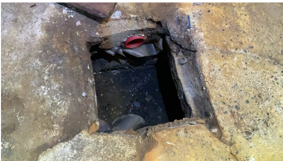
Slukanordning i gulv, påregnelig steinveite eller lignende.
