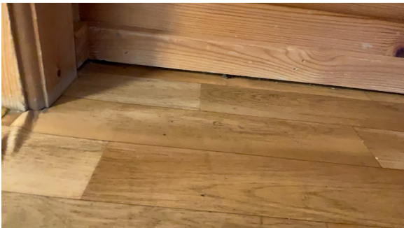
Gliper mellom listverk og gulv
