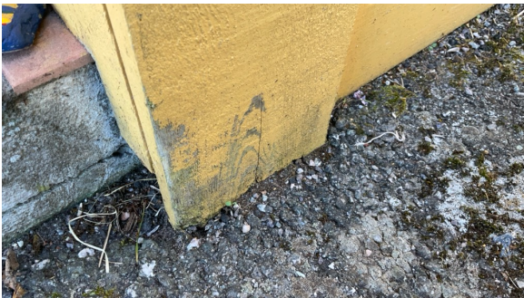
Kort/ingen avstand til terreng - enkelte råteskadde bord
