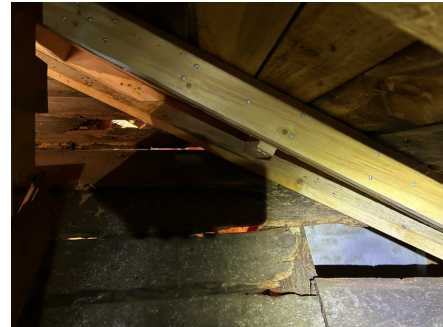
Forsterkning utført ved gradrenne vest
