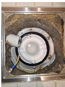
Vanntett sjikt / membran i gulv og vegger - Sluk bad
