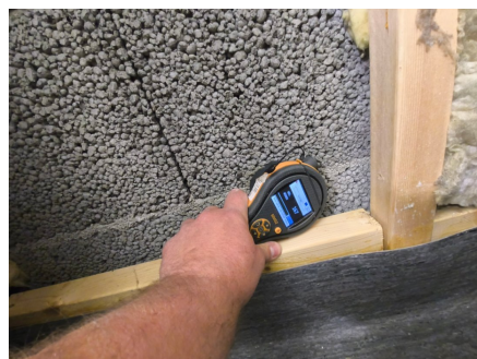
Ved enkle fuktsøk med fuktindikator registrerte jeg ingen unormale verdier.
