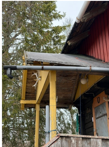
Tak over inngangsparti.
