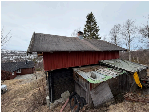
Baksiden av hovedtaket
