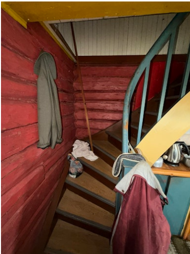
Trapp til 2. Etasje
