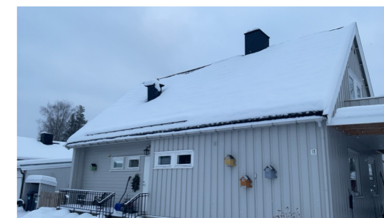
Snødekket tak ved befaringen.
