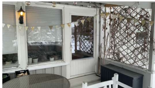
TG 1 Balkonger, terrasser og rom under balkonger
