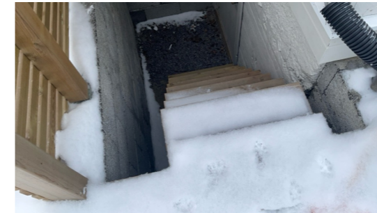
Impregnertrapp i utvendig kjellernedgang.
