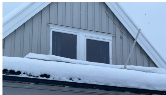
Balkongdør i 2. etasje.
