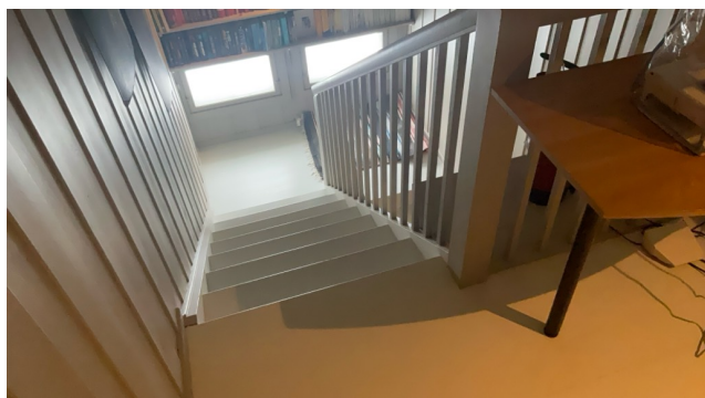
Trapp sett ned fra 2. etasje. Rekkverk med høyde på ca. 88 cm.
