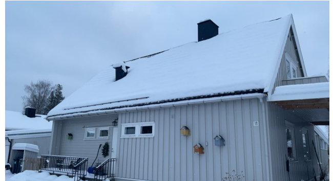
Snødekket tak ved beifaringen.
