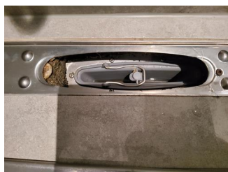
Tettesjiktets tilslutning til sluk - Sluk i dusjsonen.
