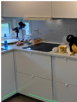
Det er ikke montert komfyrvakt
