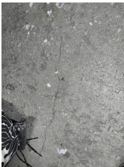
Fundament, grunnmur og gulv mot grunn - IMG_20260209_122408
