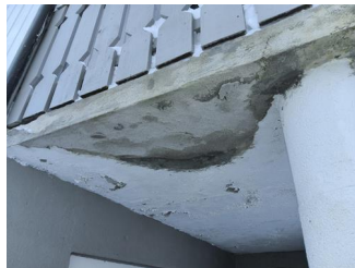
Membraner og vanntett sjikt - IMG_20260209_121824
