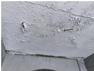
Membraner og vanntett sjikt - IMG_20260209_121807
