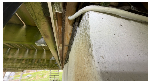
Viser lite lufting på vegg mot sør
