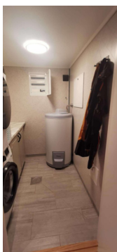
Varmtvannstank i innredning høyskap
