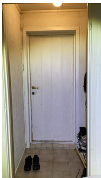
Ytterdør til leilighet er mye skadet i nedkant.
