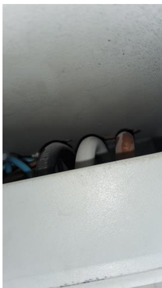
Forenklet vurdering av det elektriske anlegget - [Utettheter i sikringsskap i overkant]
