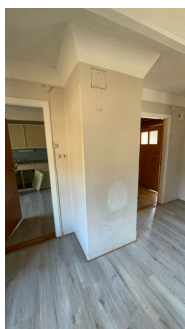
Pipe på hovedstue i 1 etasje. kun 3 synlige pipevanger.
