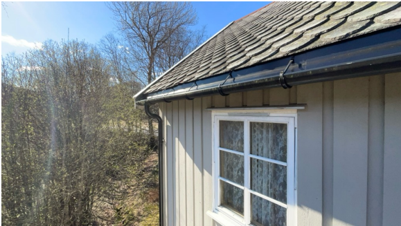
Nedløp og beslag hovedtak mot sør.
