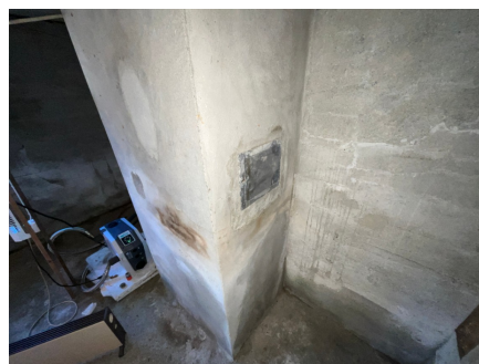
Sotluke i kjelleretasjen
