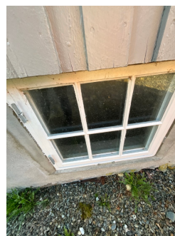
Vindu med koblet glass i kjelleretasjen.
