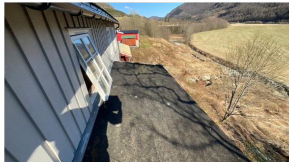
Pappshingeltak over kjøkken og bad.
