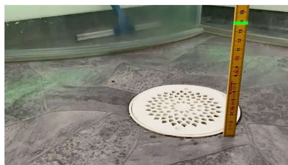
Måling av fall. målepunkt ved sluk.
