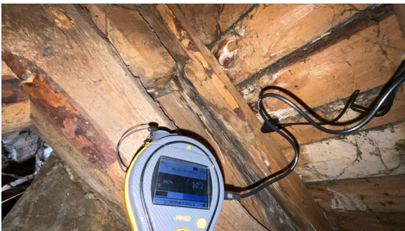
Ingen tegn til forhøyet fuktverdi i taktro og sperrer ved eldre fuktskjolder.
