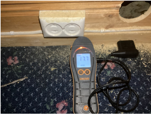
Bilde av fuktsøk
