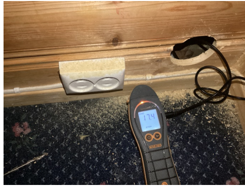
Bilde av fuktsøk
