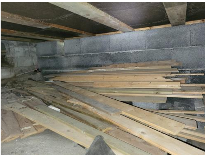
Krypekjeller - [Krypkjeller under tilbygg ]
