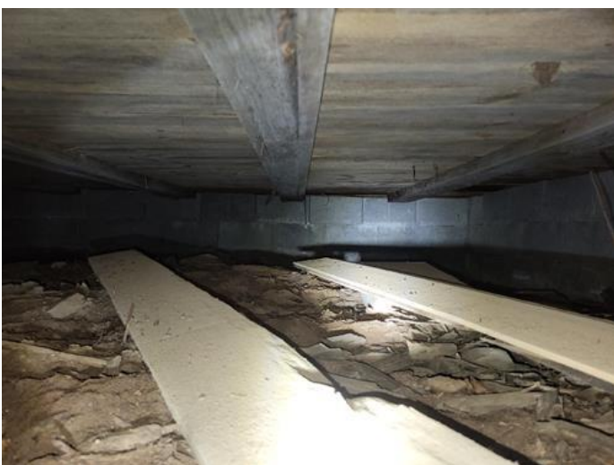
Krypekjeller - [Krypkjeller under opprinnelig del]
