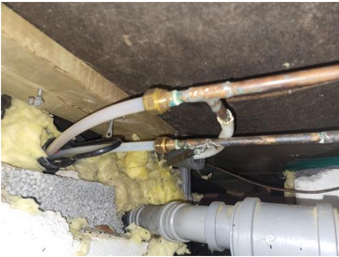
Tekniske anlegg, VVS anlegg (Sjekkpunkter utover det som er inkludert i andre rom) - [Røropplegg i krypkjeller under tilbygg]
