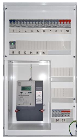
Forenklet vurdering av det elektriske anlegget - [Sikringsskap leilighet]
