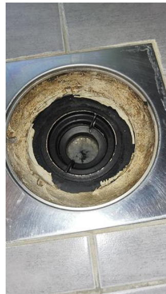
Avløpsrør (ink. sluk) - [Sluk bad leilighet]
