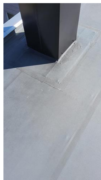
Konstruksjon - [Området uten tilstrekkelig underlag]
