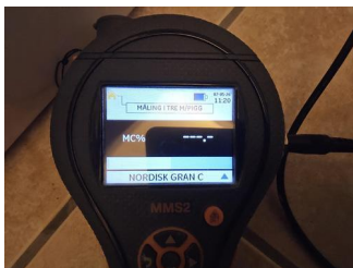
Utført kontroll i tilliggende konstruksjon - Fuktmåling bad.
