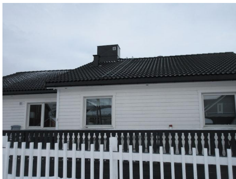
Taktekking med takstige.
