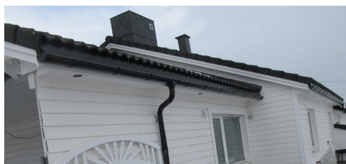
Takrenner og nedløp.
