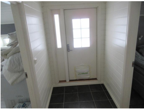
Kattehull i dør i sokkeletasjen.
