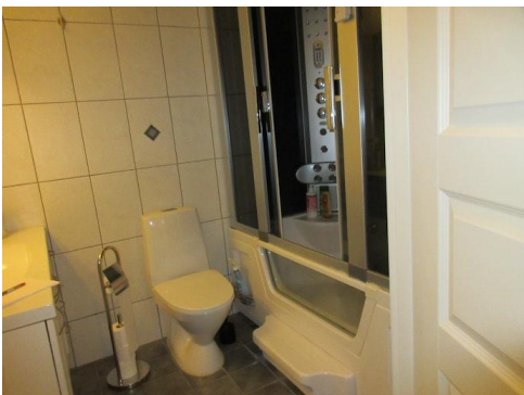
Stemdusj og WC på bad i sokkeletasjen
