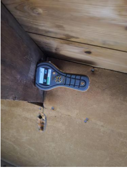
Synlige overflater (taktro, vegger, gulv, o.l) - Fuktmåling
