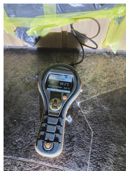
Kontroll i lukkede konstruksjoner - Fuktmåling
