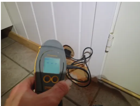
Fuktmåling i vegg til bad viser ingen tegn til avvik.
